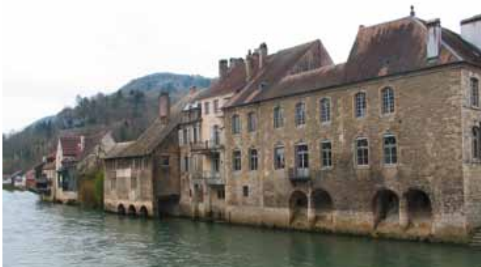
L'ensemble des bâtiments, avant leur transformation.
