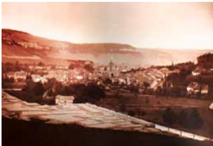
Vue générale d'Ormans ; le chalet et l'atelier sont visibles au second plan après les dalles de béton et basalte de la future voie ferrée.
